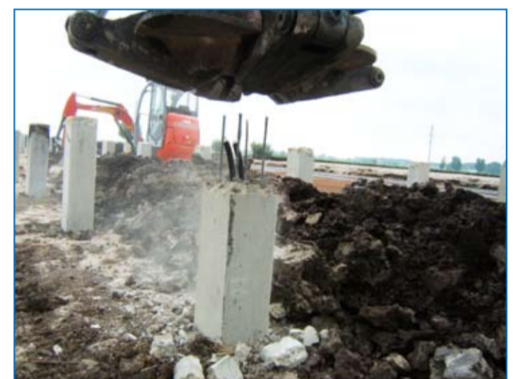
Paal zoals geheid en voorzien van warmtecirculatiepakket
