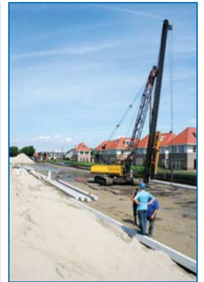
Het ophangen van een heipaal Heimachine aan het heien in een kraan
